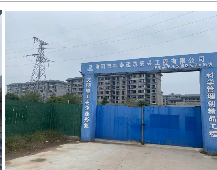
厂区北侧王庄安置小区
