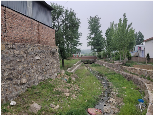
厂区东侧河沟
