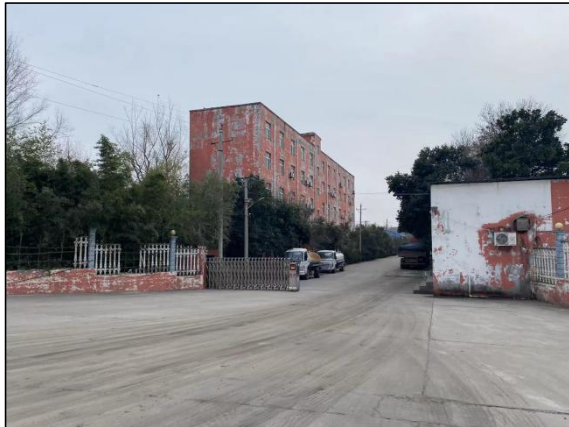
项目厂区东侧洛阳得天有限公司
