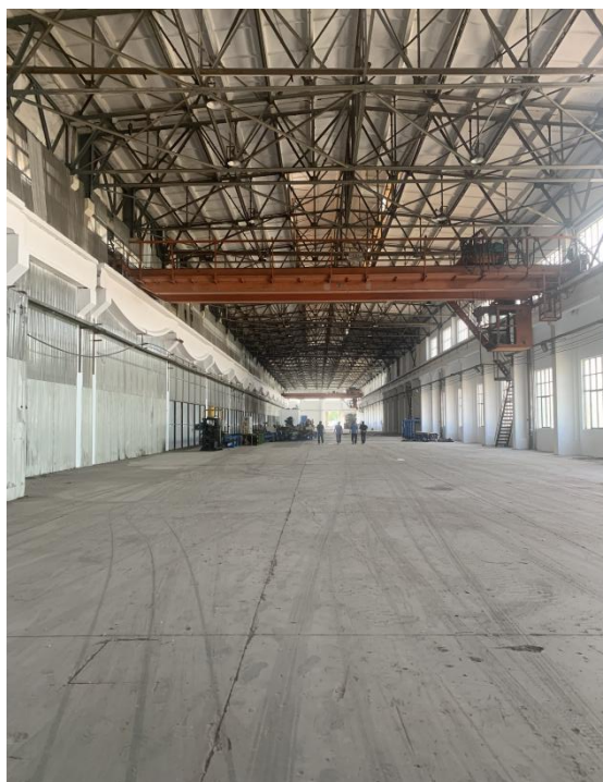
生产车间内部
