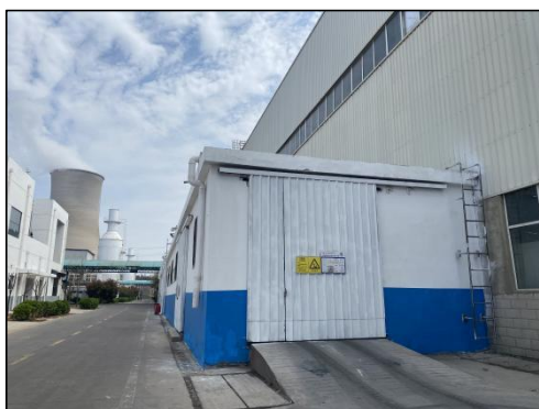
项目现有危废暂存间
