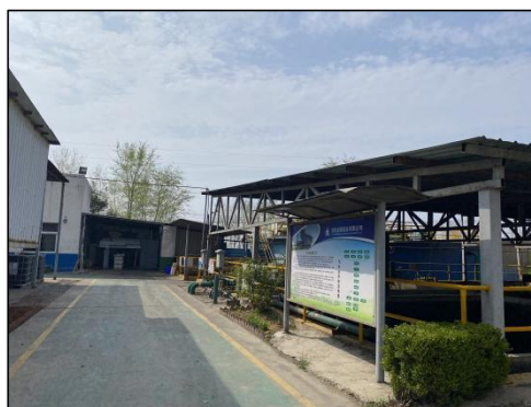
项目现有污水处理站
