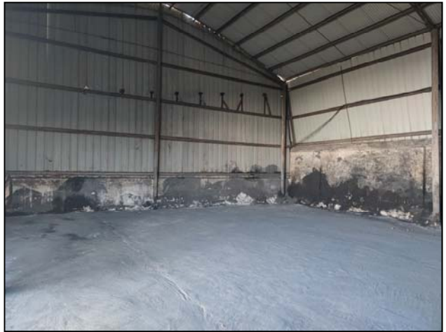
项目车间现状
