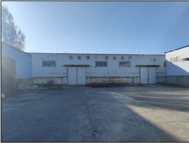
项目厂区现状
