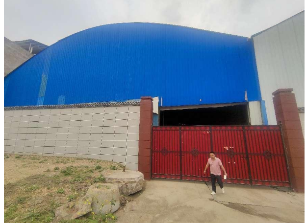
项目厂区大门
