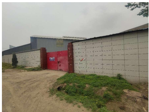
项目南侧空置厂房
