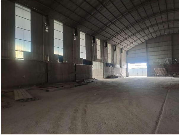
项目车间现状照片
