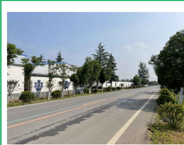
白梁线（厂区西侧）
