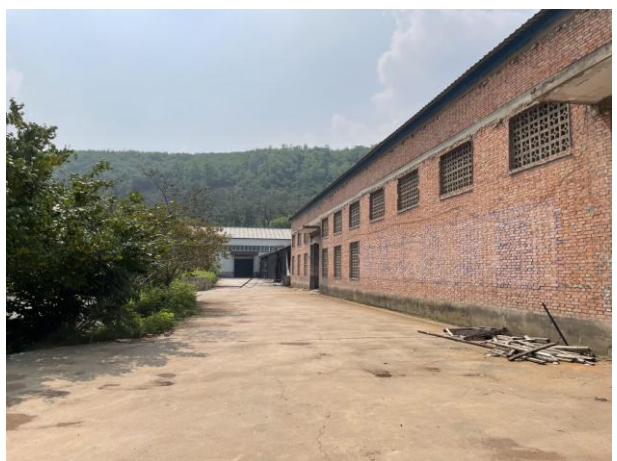
项目厂区现状
