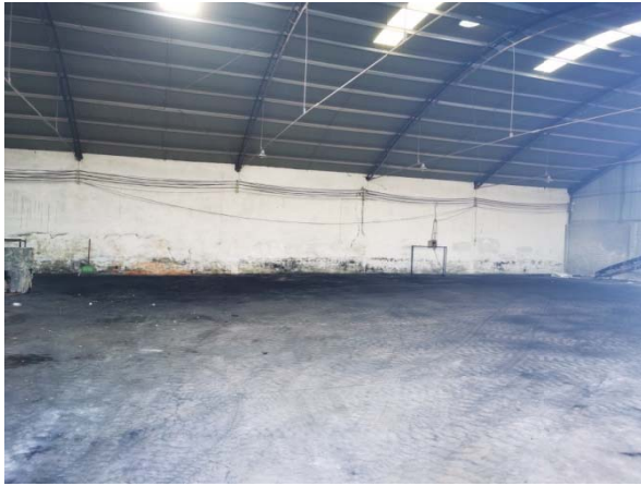
车间内原有设备已清空后照片
