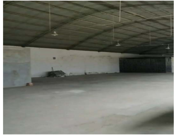
车间内原有设备已清空后照片
