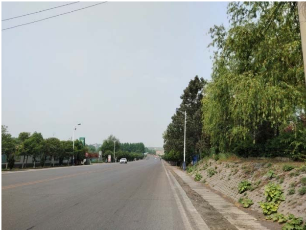
厂区南侧道路
