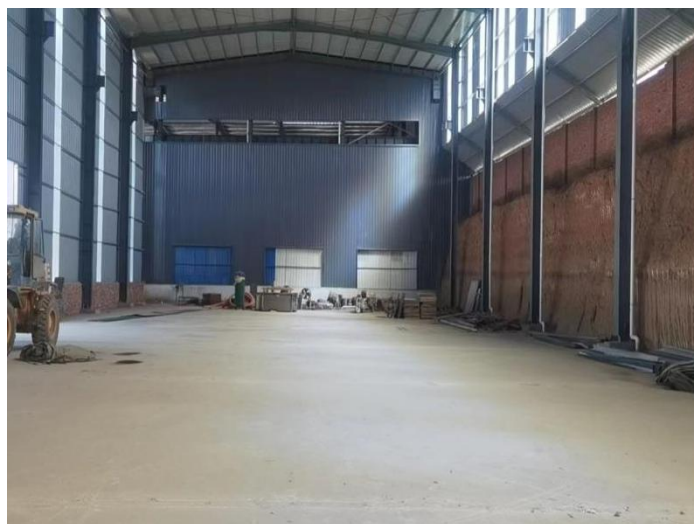
生产车间内部
