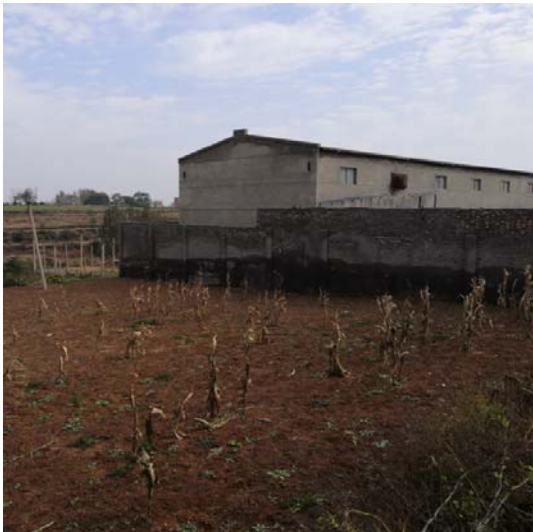
项目厂区西侧
