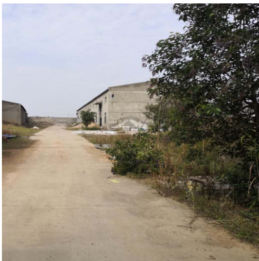
项目厂区现状
