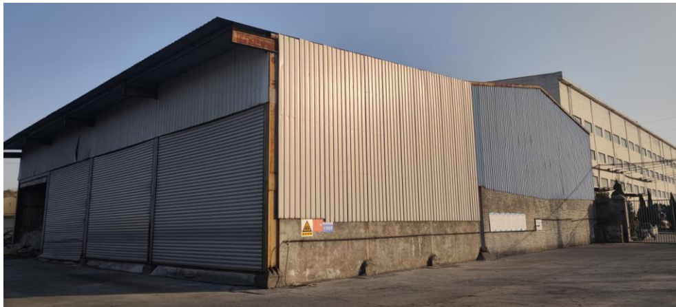
1#大修渣库现状
