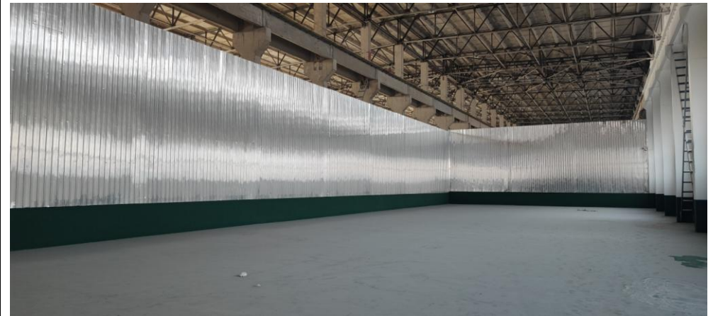
2#大修渣库现状
