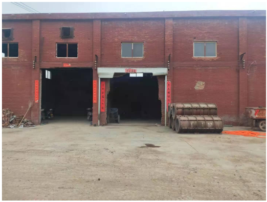
项目钢筋加工车间现状
