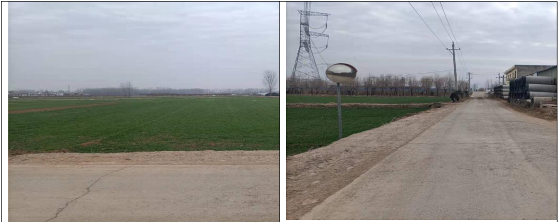
厂区北厂界道路
