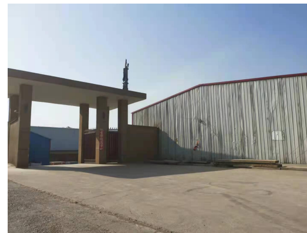
项目东侧闲置厂区
