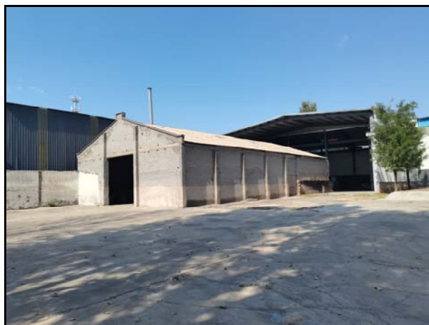
厂区废弃车间
