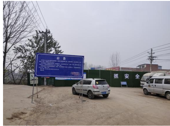
干河桥北侧（起点、围挡）
