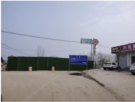
干河桥南侧（终点、围挡）
